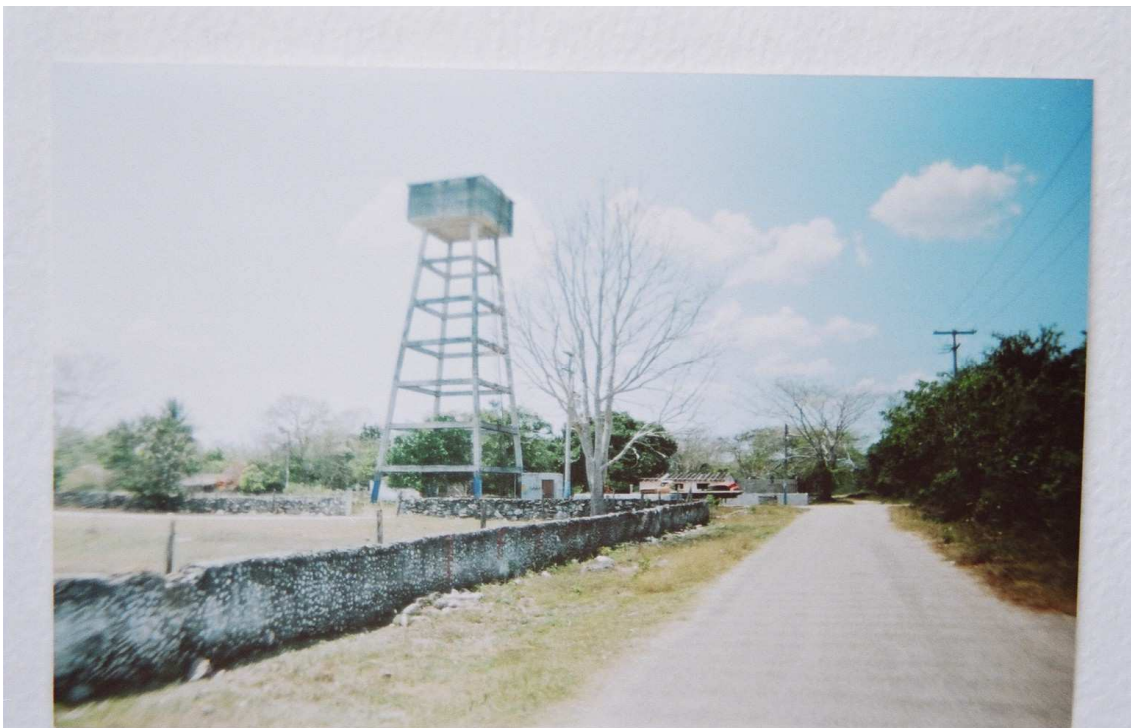
Foto Num. 8.- Torre de agua la cual abastece a esta comunidad ejidal de Justicia Social, se puede observar también la pavimentación de algunas calles principales.
