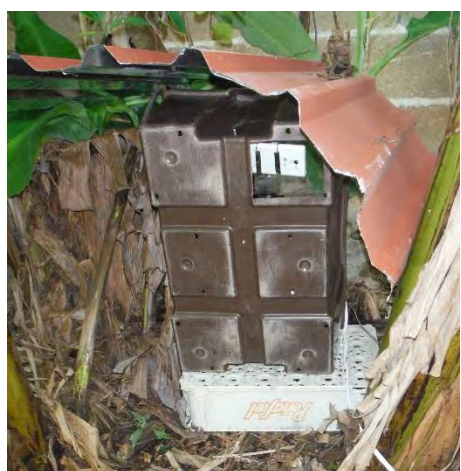
Fotografía 4. Montaje del dispositivo
