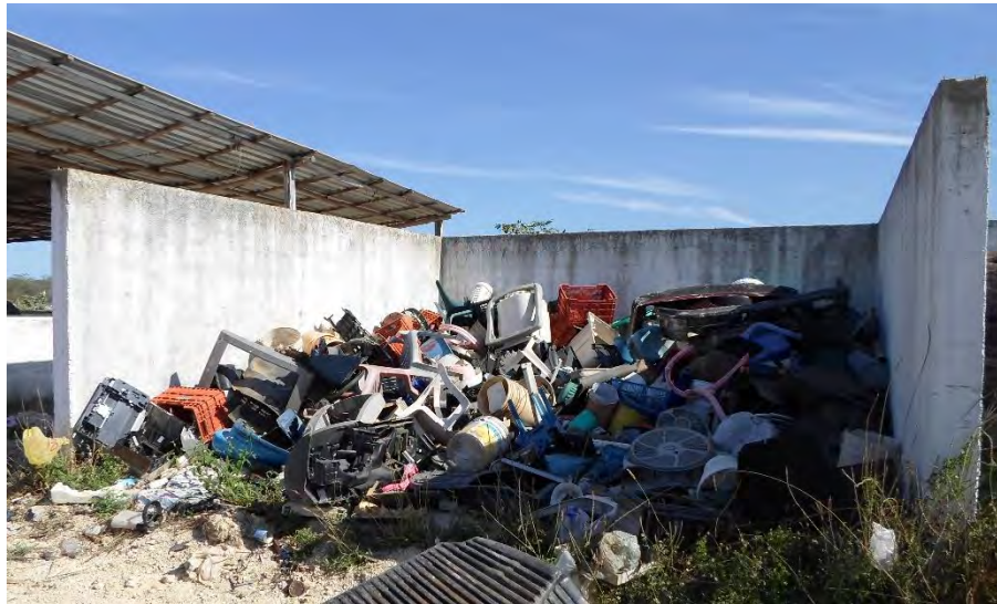
Imagen 36. Celda de separación.
