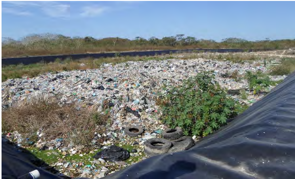
Imagen 33. Celda de compactación.
