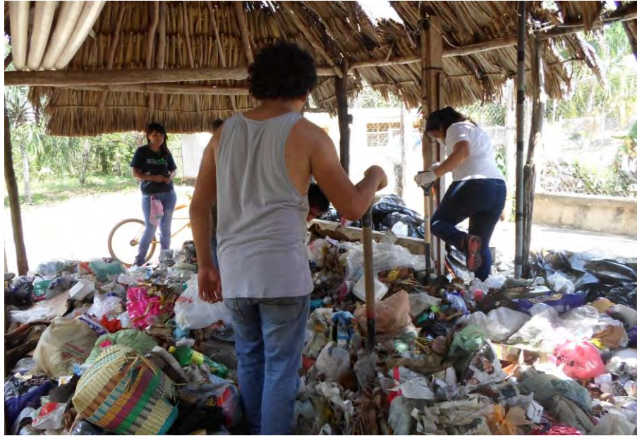
Imagen 7. Método del cuarteo (homogenización de los residuos con una pala y tridente)
