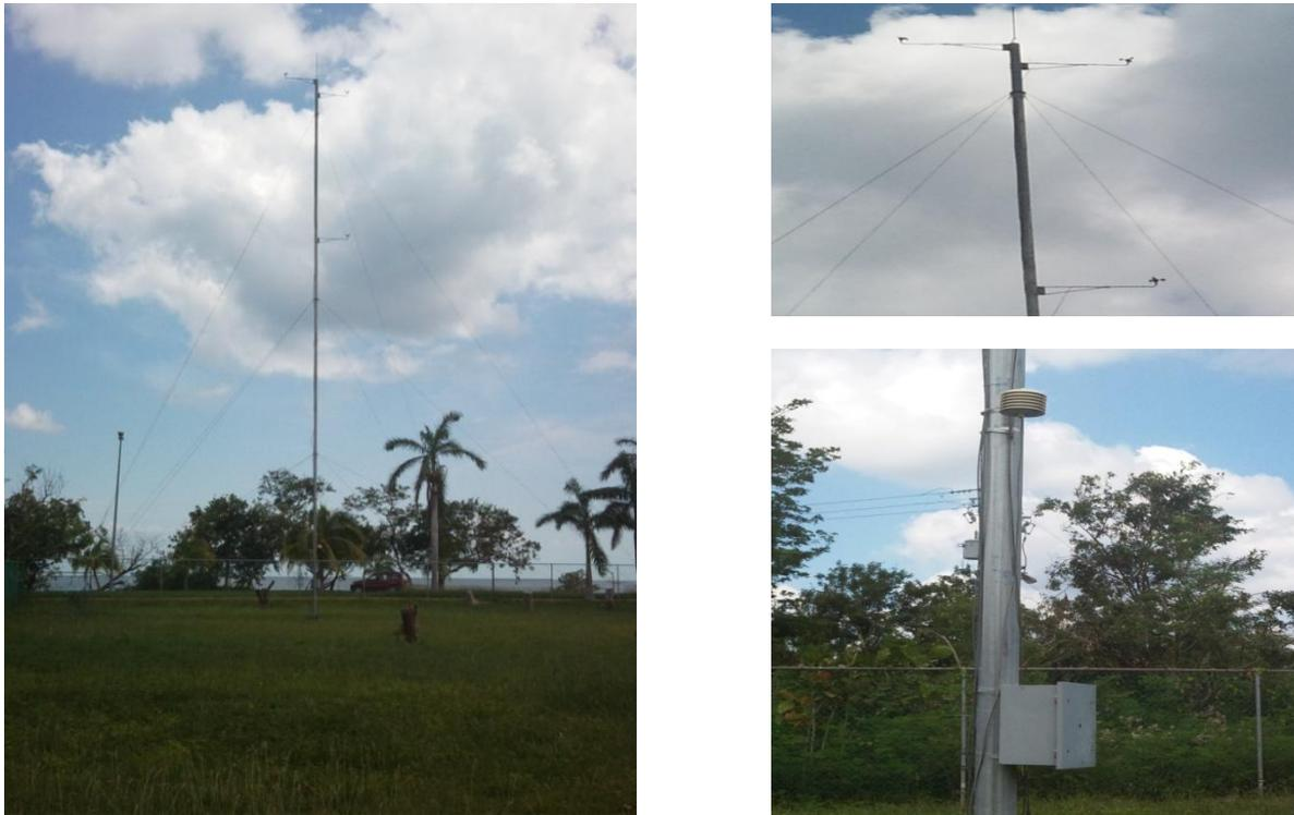
*Figura 3.12 Estación Anemométrica de la UQRoo.*
