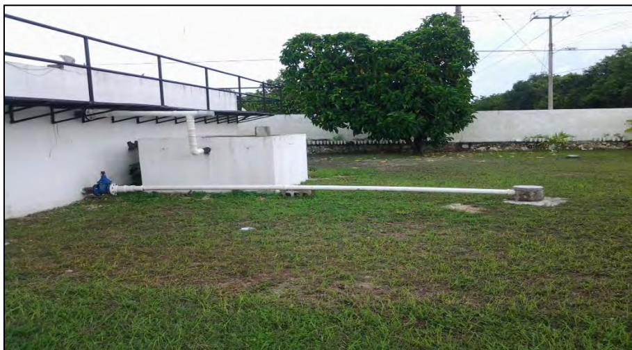
Figura 3.15 Pozo de absorción.
