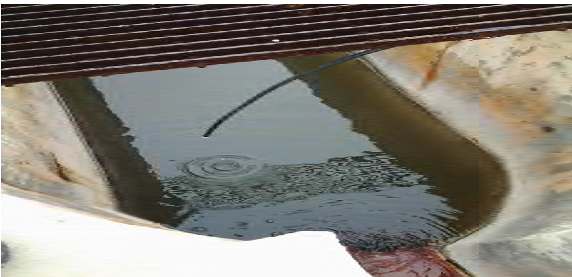
Figura 3.13 Manguera con la que se agrega cloro al agua tratada.
