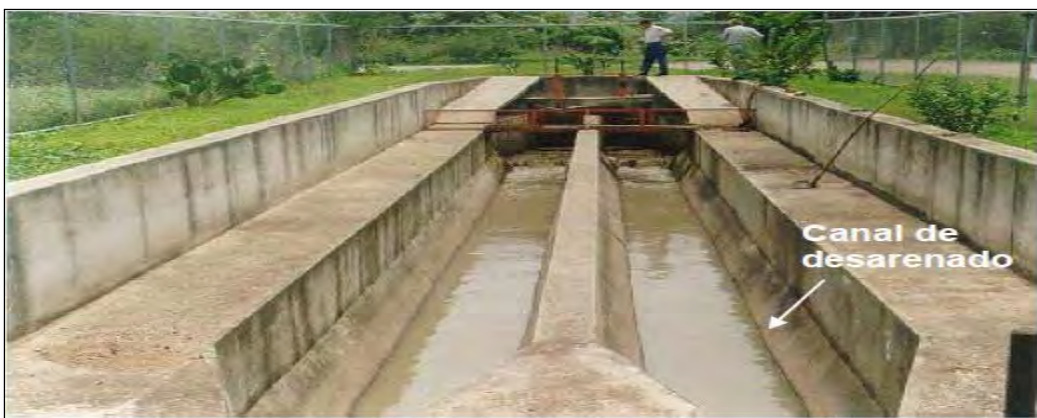
Figura 2.4 Desarenador de dos canales. Fuente: Escalante et al. 2003.
