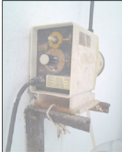
Figura 3.12 Equipo de golpeo para la adición de Hipoclorito
