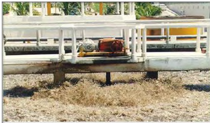
Figura 2.9 Aireador mecánico.
