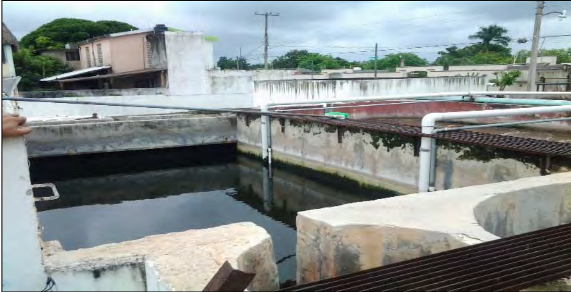
Figura 3.10 Tanque sedimentador.
