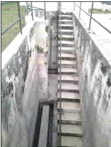
Figura 3.4 Escalera para ingresar al área de tratamiento preliminar
