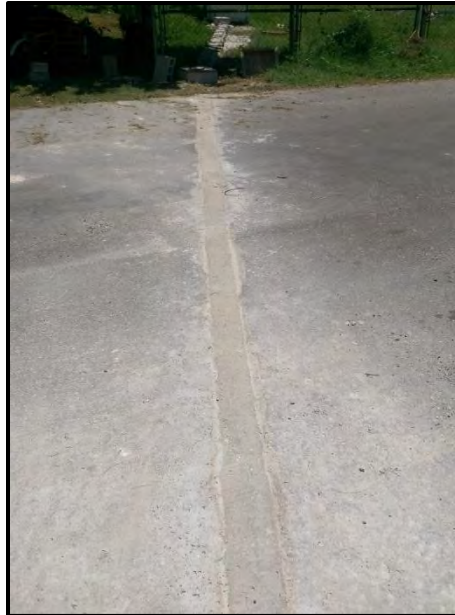
Figura 26. Corte transversal realizado a la carretera.
