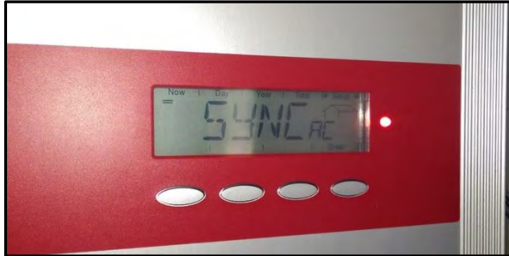
Figura 35. Inversor Fronius sincronizando con la red eléctrica.
