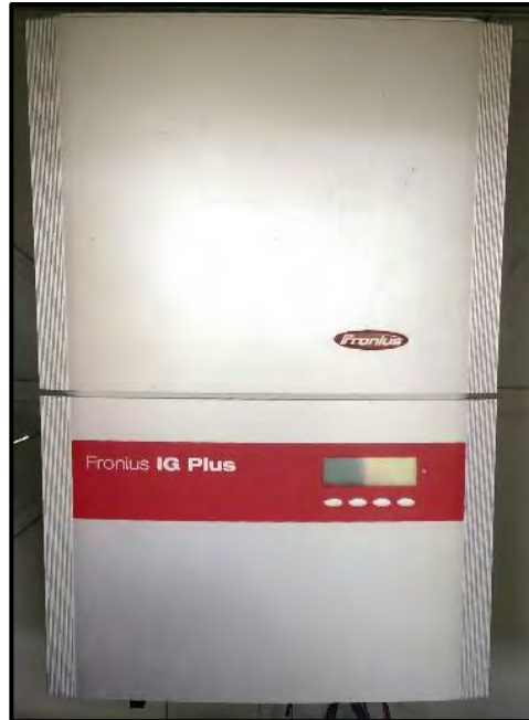
Figura 19. Imagen de inversor Fronius IG Plus V 3.0-1 UNI de 3 kW
