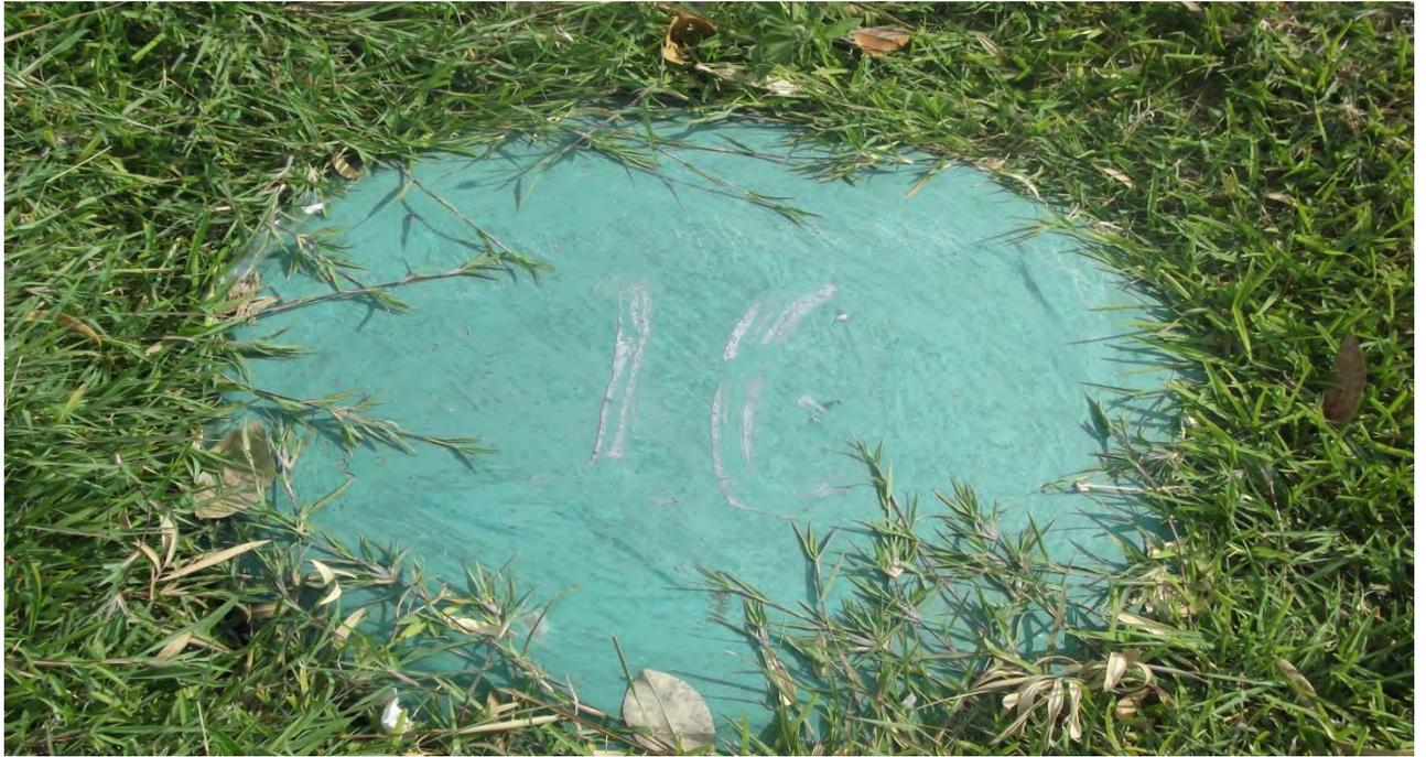
Imagen 28. Este drenaje esta en el camellón entre el parque los caimanes y la iglesia; este tipo de drenajes a traído problemas a los habitantes de esta zona ya que todas las aguas negras se regresan a sus casas debido a que uno un hundimiento en la calle y esto modifíco las tuberías.
