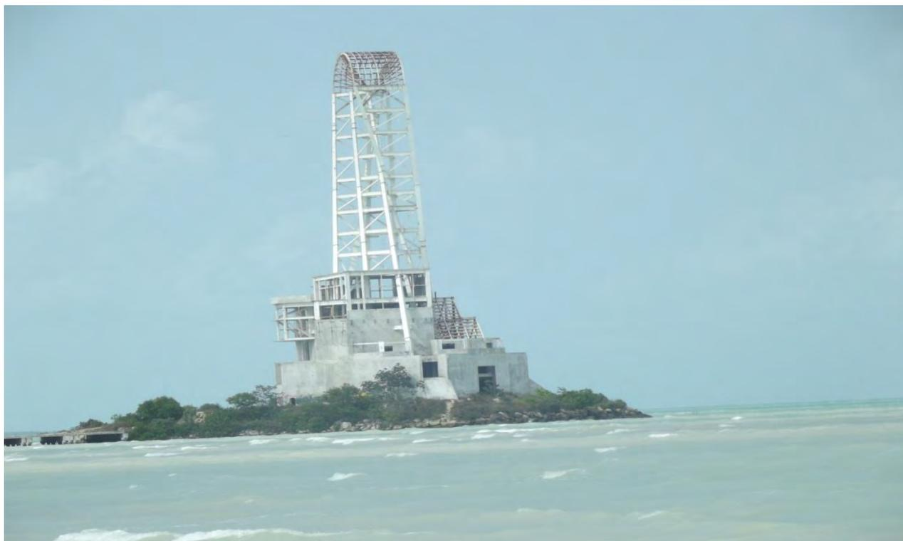
Imagen 27. La “Mega escultura” lleva más de 10 años en construcción y aun sigue inconclusa, con la lluvia, hay deslaves, la estructura se oxida y esa contaminación va directo a la bahía.
