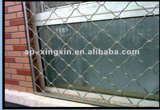
Ventanas con herrería herrería tejida o entrelazada
