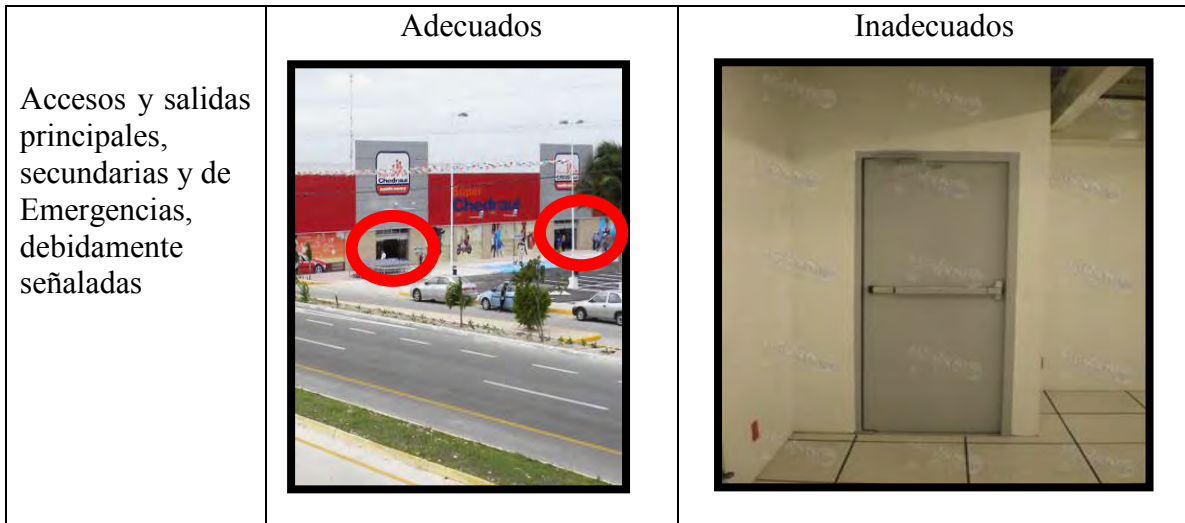
Imagen. 4 Accesos y salidas principales, secundarias y de emergencias, debidamente señaladas.
