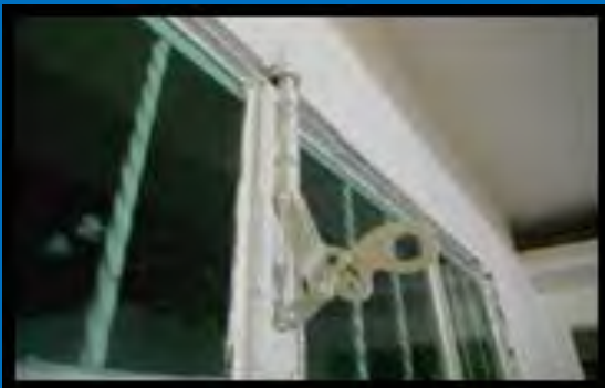
Puertas y ventanas reforzadas desde el interior, como las de palanca
