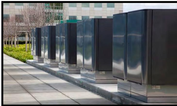
Figura 23. Planta de celdas de combustible tipo SOFC de 100 kW de la NASA [65].
