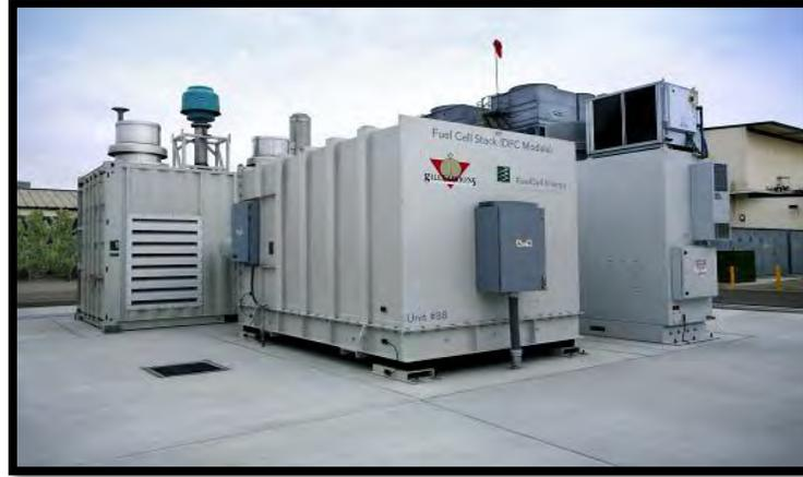
Figura 22. Planta de celdas de combustible tipo MCFC de 600 kW [63].
