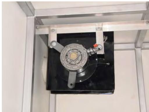
Figura 4.13 Ventilador de aire primario instalado.
