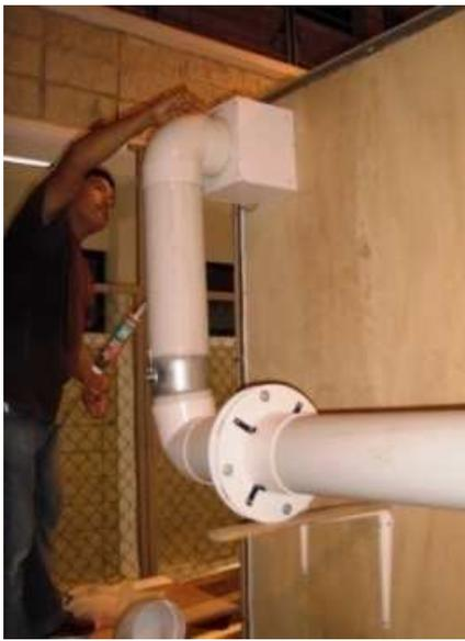
Figura 4.16. Ducto de aire primario acoplado a la placa de orificio, al d mper y al ventilador
