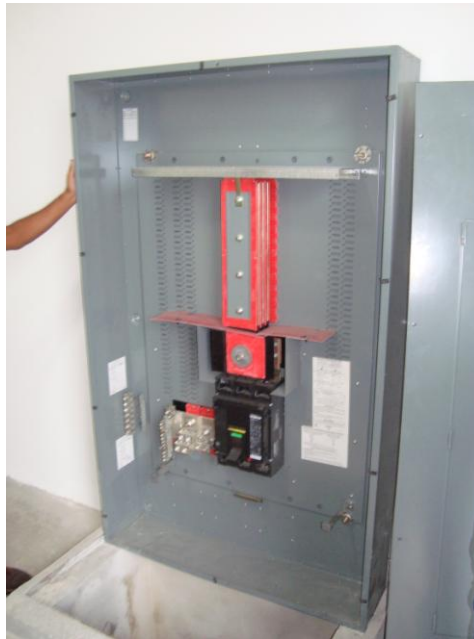
Fig. 5.13 Tablero I-Line no instalado.
