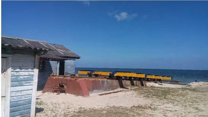
Imagen 21. Infraestructura para mantenimiento de los botes de pesca (astillero y muelle).
