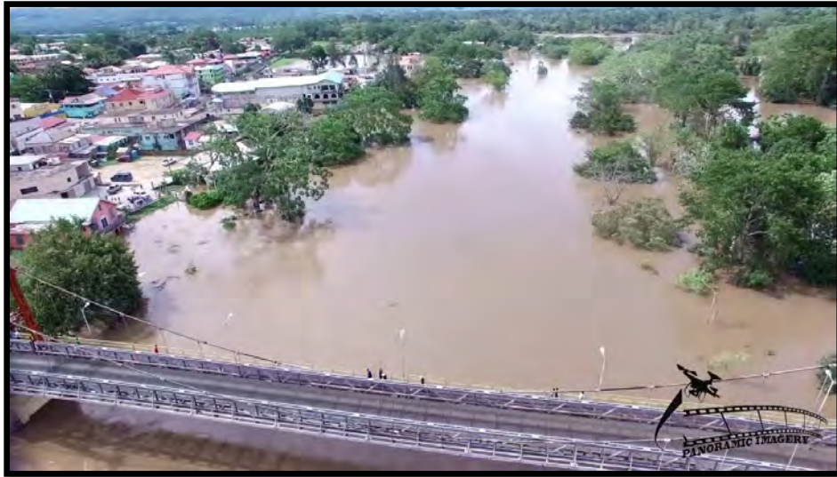
Fig. 14. Inundación causada por el huracán Earl.
