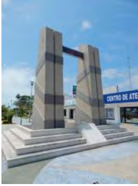
Imagen 10 Torre de reloj instalada en 2016
