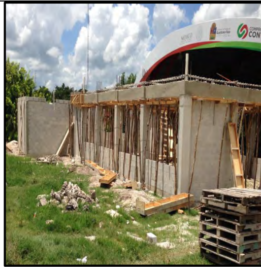
Construcción de Comedor Comunitario, Localidad de Francisco Villa, Othón P. Blanco, 2016
