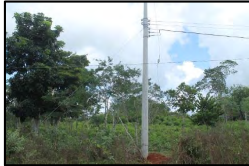
Ampliación de la Red Eléctrica de Media tensión, Localidad de Lázaro Cárdenas del Rio Tercero, Bacalar, 2014
