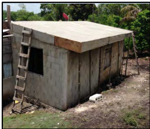
Construcción de Cuarto Dormitorio, Localidad de Cacao, Othón P. Blanco, 2016
