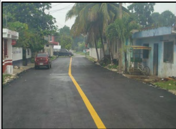
Construcción de Pavimentación, Localidad Bacalar, Colonia 5 de Mayo, Bacalar 2015
