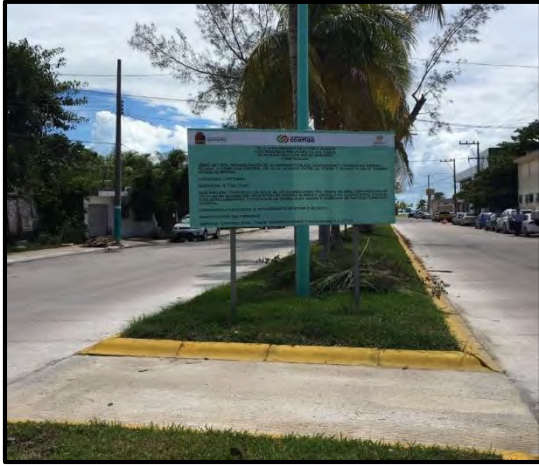
Construcción Rehabilitación de Guarniciones y Banquetas, Calle Central de la Av. Hidalgo y Calle Othón P. Blanco
