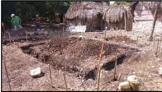
Construcción de Cuarto, Localidad de Andrés Quintana Roo, Bacalar, 2016
