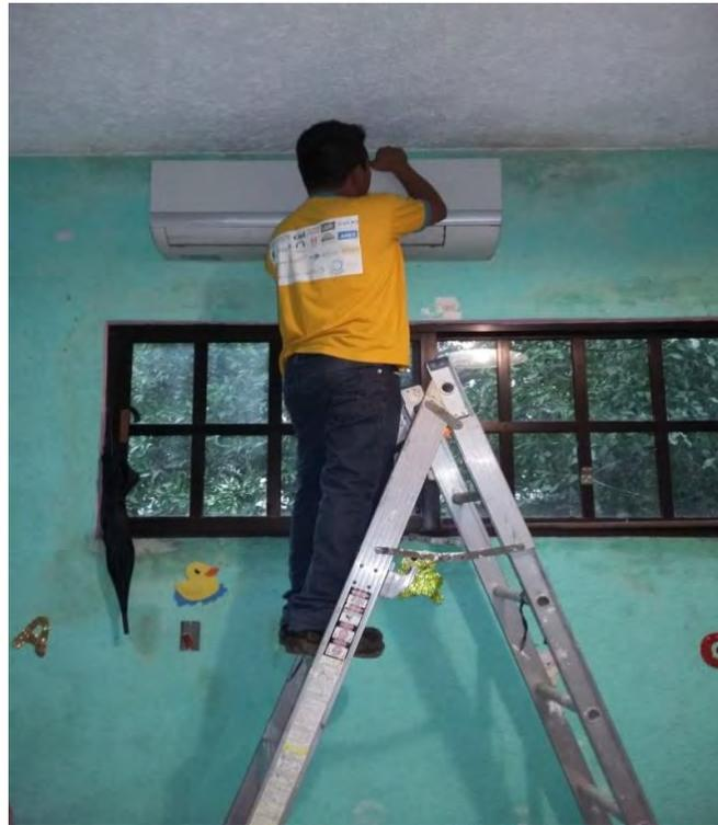
*Figura 3.11 Instalando el evaporador (Fuente: elaboración propia).*
