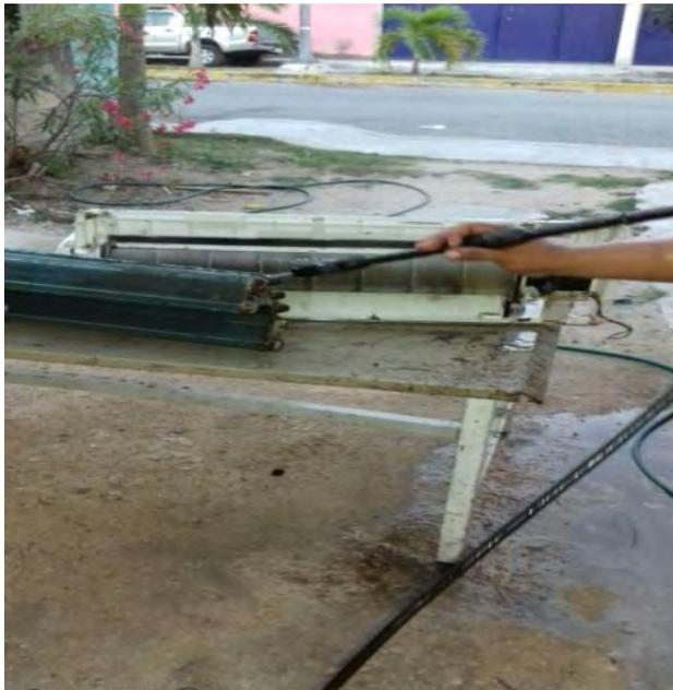
*Figura 3.9 Lavado de serpentín y demás partes del evaporador (Fuente: elaboración propia).*
