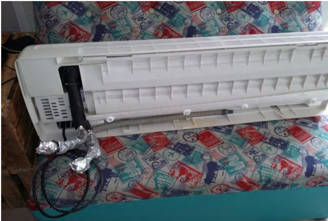
*Figura 3.6 Tuberías encintadas en ambos extremos del evaporador (Fuente: elaboración propia).*
