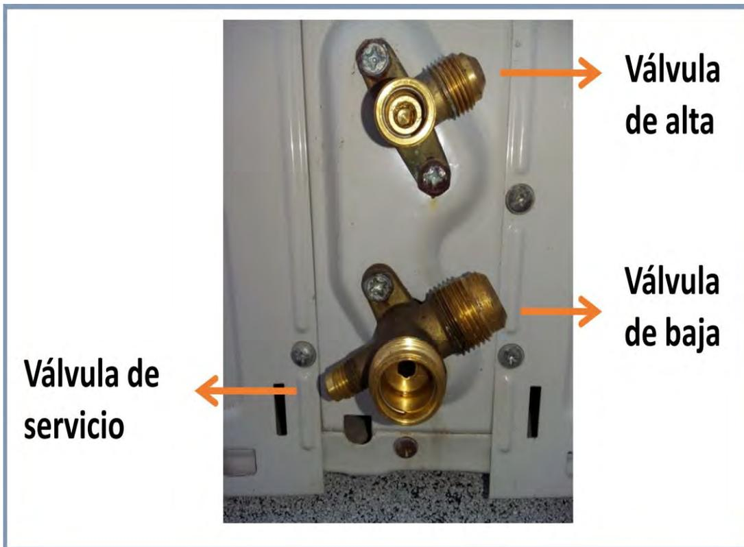
*Figura 3.1 Válvula de alta, válvula de baja y válvula de servicio (Fuente: elaboración propia).*
