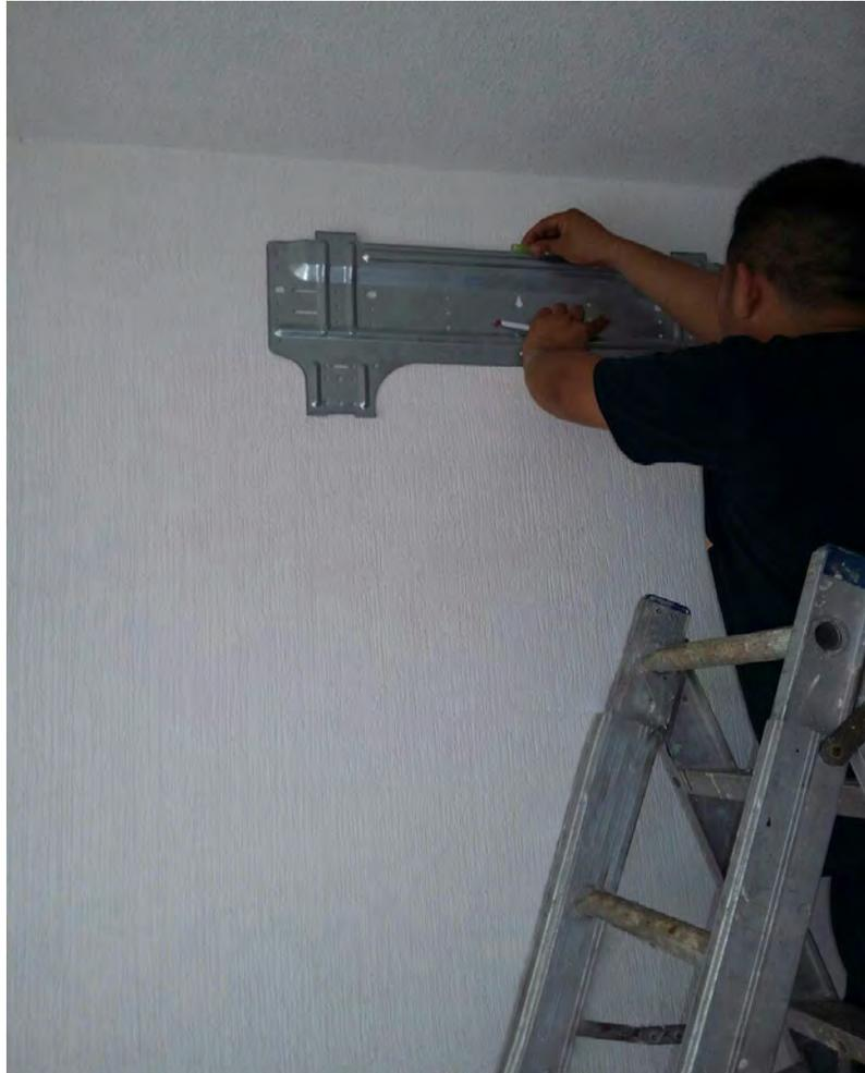
*Figura 3.7 Gancho de soporte del evaporador (Fuente: elaboración propia).*
