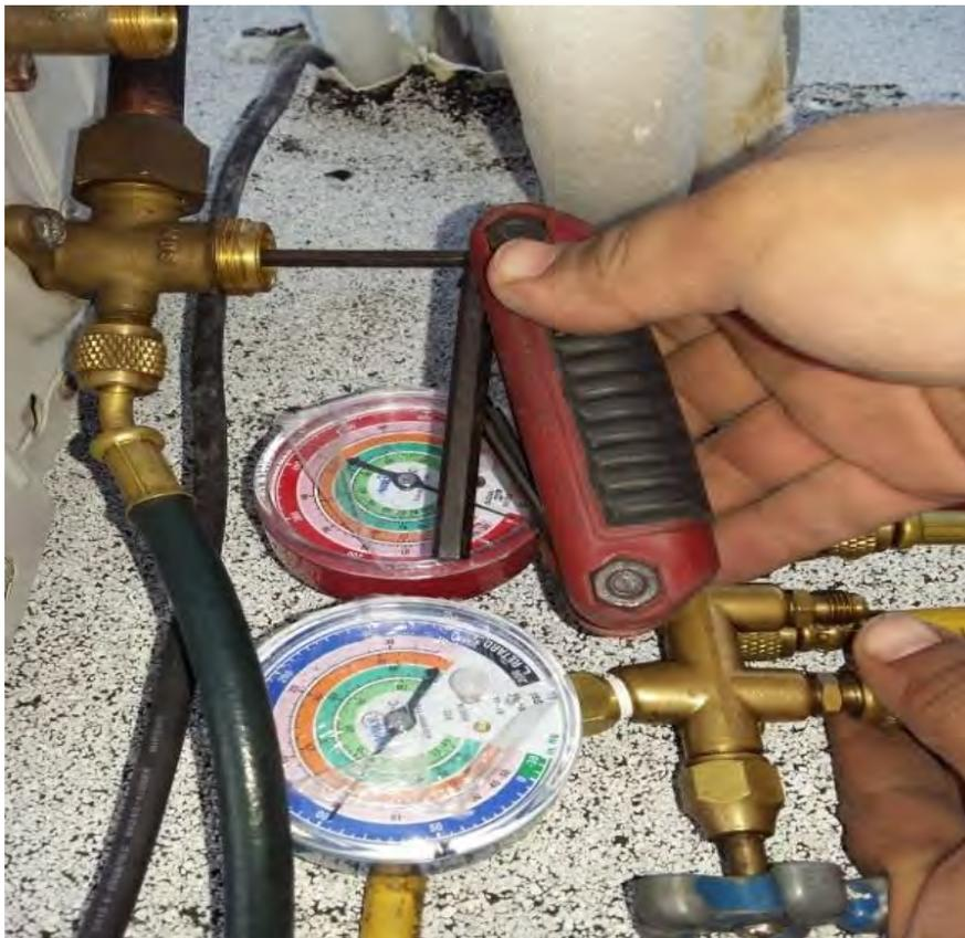
*Figura 3.2 Manómetro conectado al puerto de servicio (Fuente: elaboración propia).*
