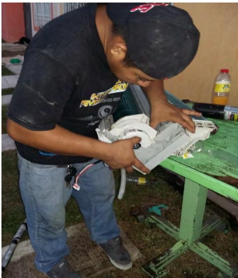
*Figura 3.8 Desconectando la tarjeta del evaporador (Fuente: elaboración propia).*
