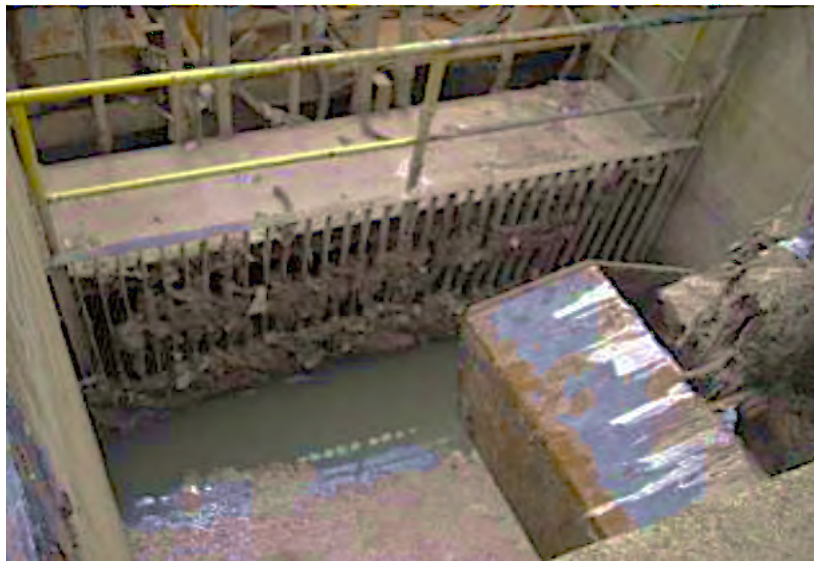
Figura 6 Desbaste empleando rejillas (Huertas et al. , 2013)
