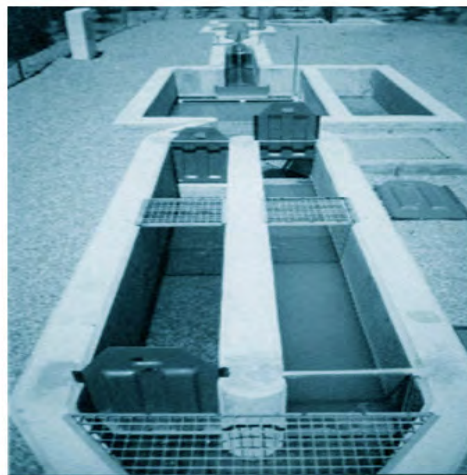
Figura 9 Desarenador con doble canal (Ng, 2006)
