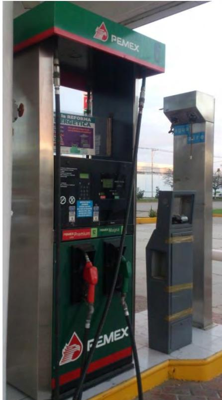
DISPENSARIO, SISTEMA DE COBRO ELECTRÓNICO Y RED DE AIRE Y AGUA A PRESIÓN.
