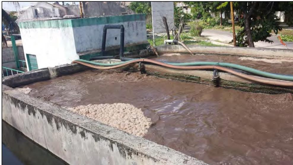
**Figura 1.3** Sistema de lodos activados aerobio de mezcla completa en la Planta de Tratamiento de Aguas Residuales Fovissste V.
