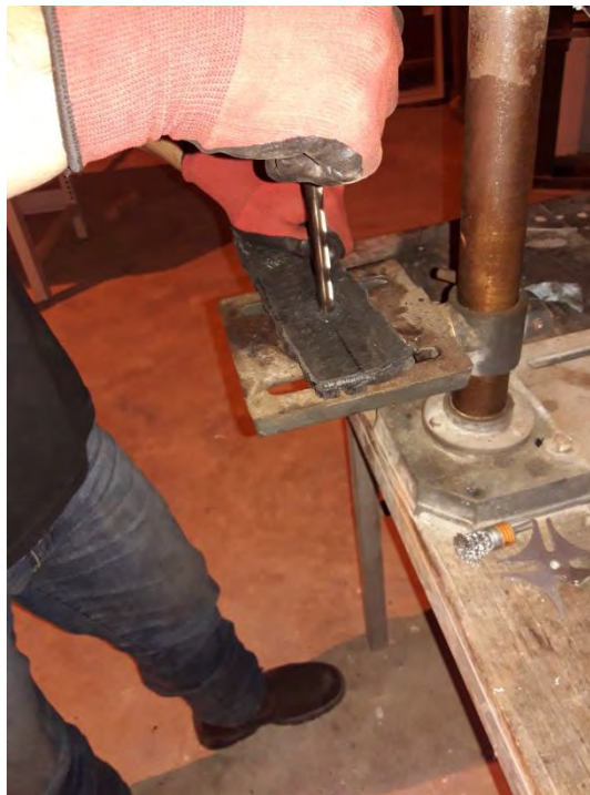
Figura 31. Fabricación de los orificios de las juntas para los nuevos tornillos.
