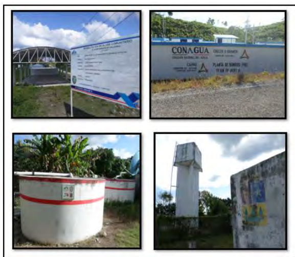
Figura 65. Infraestructura hidráulica en la zona objeto de estudio.
