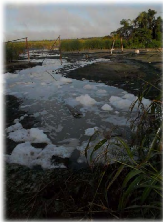
Fig. 15. Canal al cual es descargado el efluente de la planta de Tratamiento Primer Centenario.
