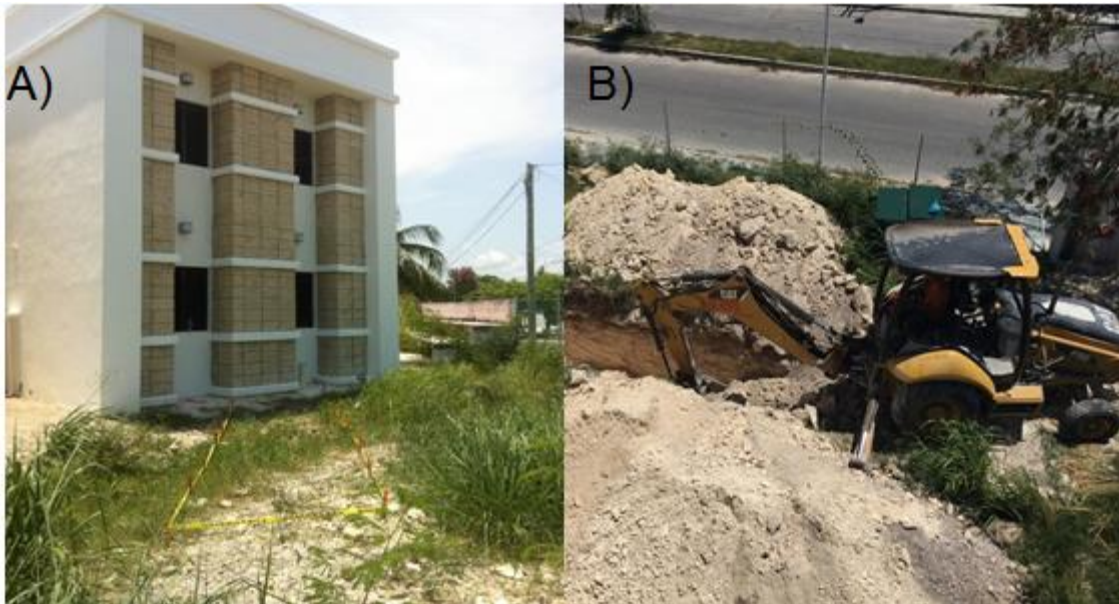
Figura 26. A) Delimitación del área para la zanja en terreno adyacente al conjunto habitacional. B) Retroexcavadora haciendo zanja para instalación del intercambiador.
