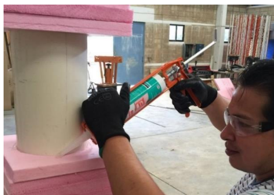
Figura 7 Unión y sellado de placas de poliestireno extruido con silicón.
