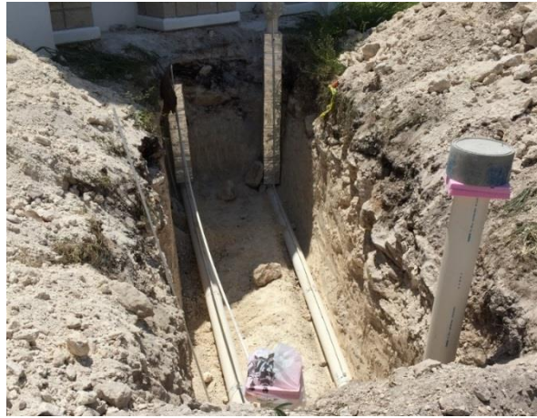
Figura 28. Colocación del intercambiador en la zanja para su instalación.
