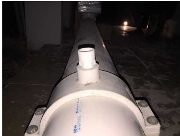
Figura 17. Colocación de abrazaderas de 6" con reducción a 1/2" para la instalación de los termopares.
