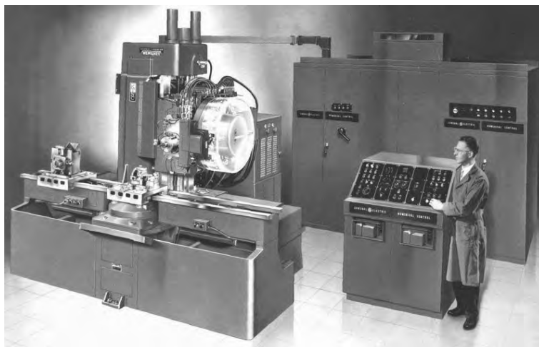
Fig. 1.1 1959 Milwaukee-Matic-II, primera CNC con cambio de herramienta [1].
