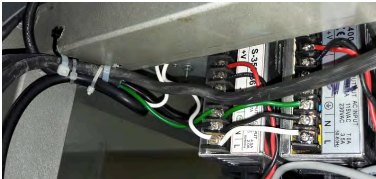
Fig. 3.13 Fijación de cables de fuentes de alimentación.
