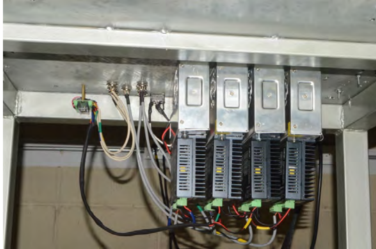
Fig. 3.5 Sistema eléctrico y de control montado debajo de la mesa de trabajo.
