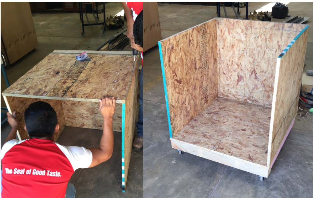
Figura 10. Ensamble de paredes rígidas
