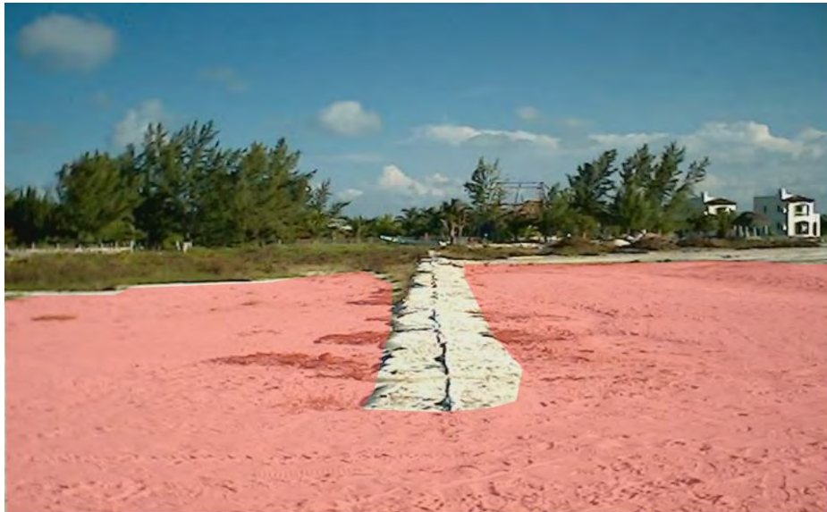
Ilustración 13: Fotografía: Zona donde se deposita la arena. Nótese como la escollera prácticamente ha quedado cubierta de arena. El Isidoro, como lo manifiestan los entrevistados, aceleró en gran medida este proceso de depósito.
