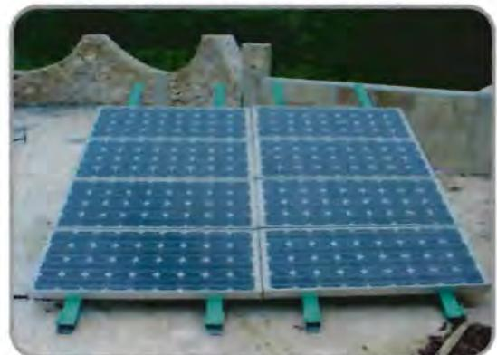
Figura 3.4 Fotografía del sistema fotovoltaico para cargas en CA.
