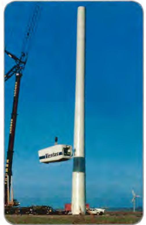
Figura 2.16 Fotografía de una torre tubular.
