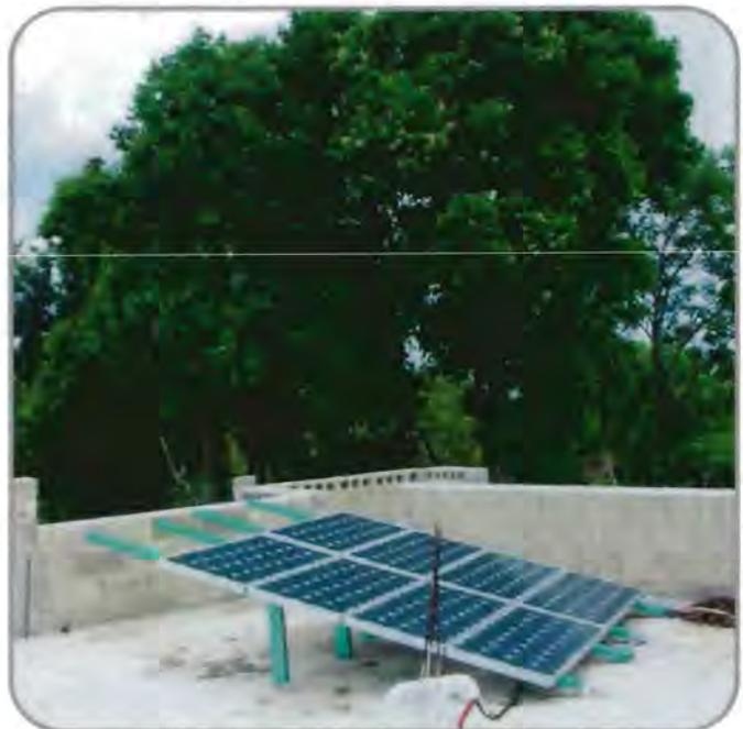
Figura 3.21 Fotografía del efecto de sombreado sobre el arreglo FV.
