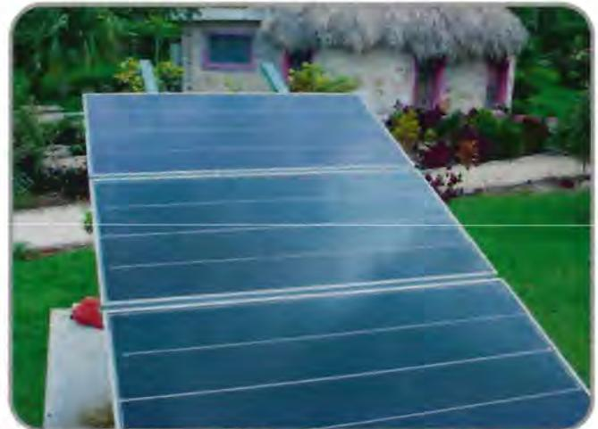
Figura 3.6 Fotografía de los módulos de silicio amorfo.
