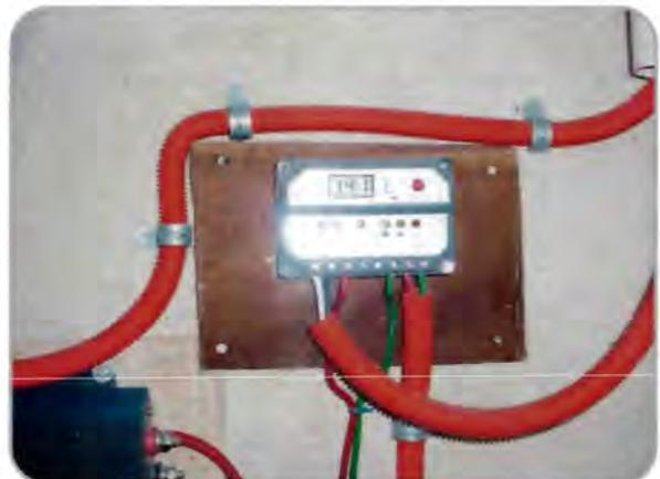
Figura 3.24 Fotografía de controlador de carga del arreglo FV.
