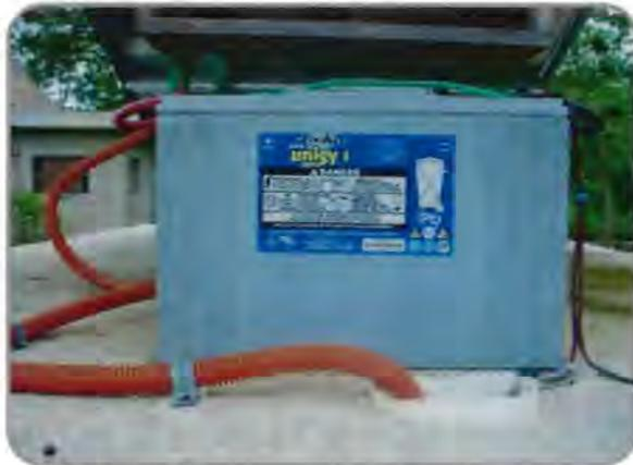
Figura 4.8 Fotografía de una batería Deka Unigy I 12AVR100.
