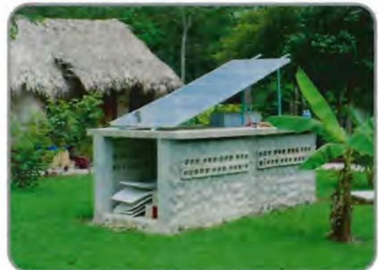
Figura 3.3 Fotografía del sistema fotovoltaico para cargas en CD.
