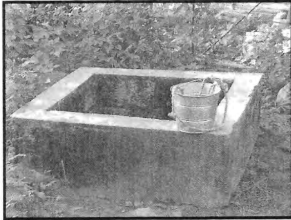
Foto 4. Fuente de abastecimiento nombrado "P-04"
