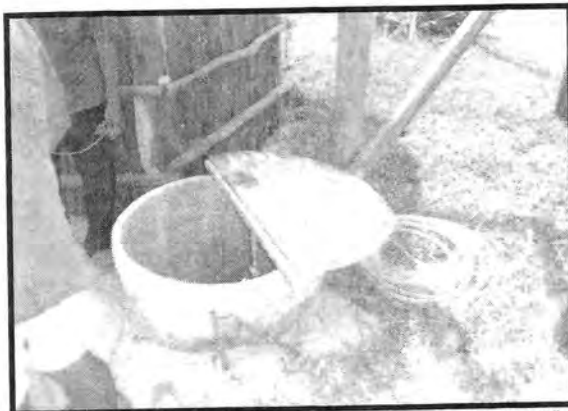
Foto 9. Fuente de abastecimiento nombrado "P-09"
