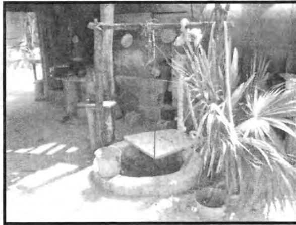
Foto 10. Fuente de abastecimiento nombrado "P-10"
