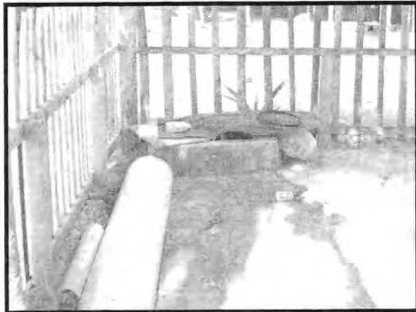
Foto 5. Fuente de abastecimiento nombrado "P-05"
