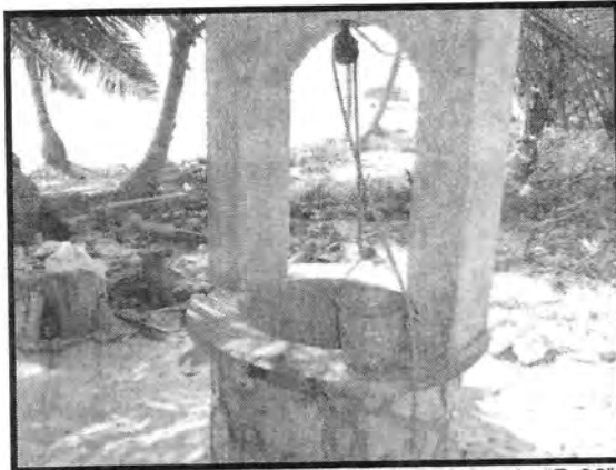
Foto 8. Fuente de abastecimiento nombrado "P-08"
