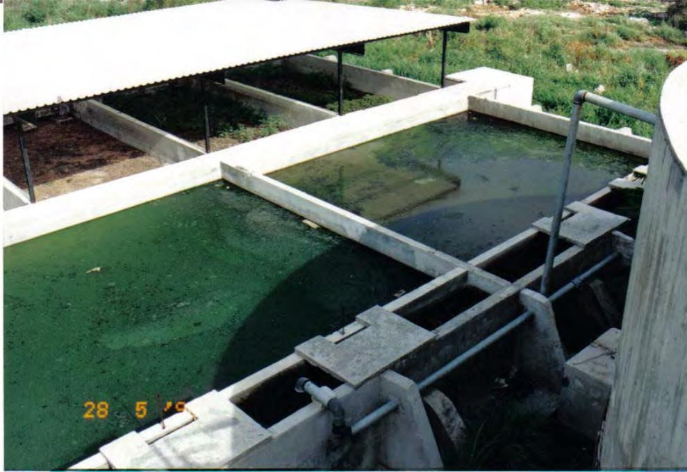
Foto 5. Filtros de arena por la separación del lodo y lechos de secados para los lodos.
