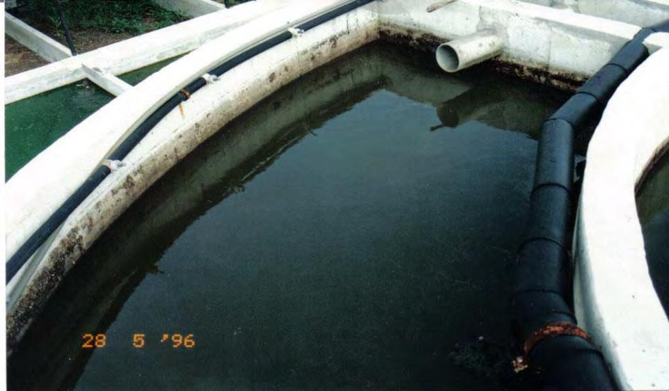
Foto1. Tanque de contacto, entrada del agua residual.
