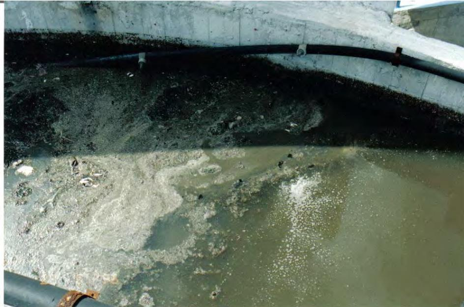
Foto 3. Vista de la manguera de 1" con rociadores, y manguera de 4" por distribución de aire.
