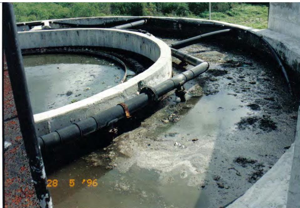
Foto 2. Tanque de estabilización, parte central corresponde al sedimentador.
