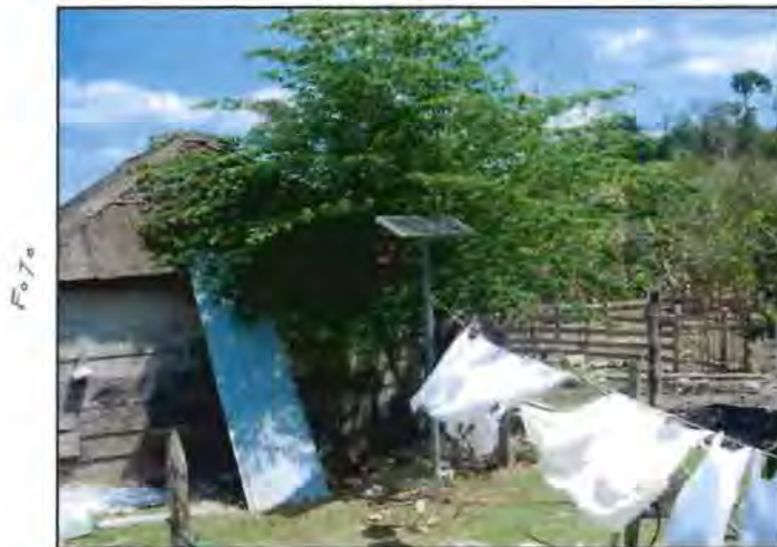
Figura 3.3 Fotografía de un módulo fotovoltaico donde se observan sombras a causa de un árbol.
