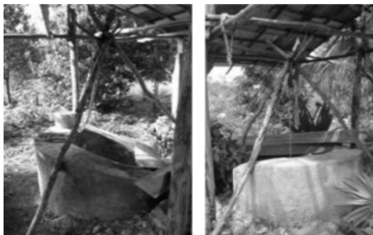
Figuras. 8 y 9. Pozo de abastecimiento
