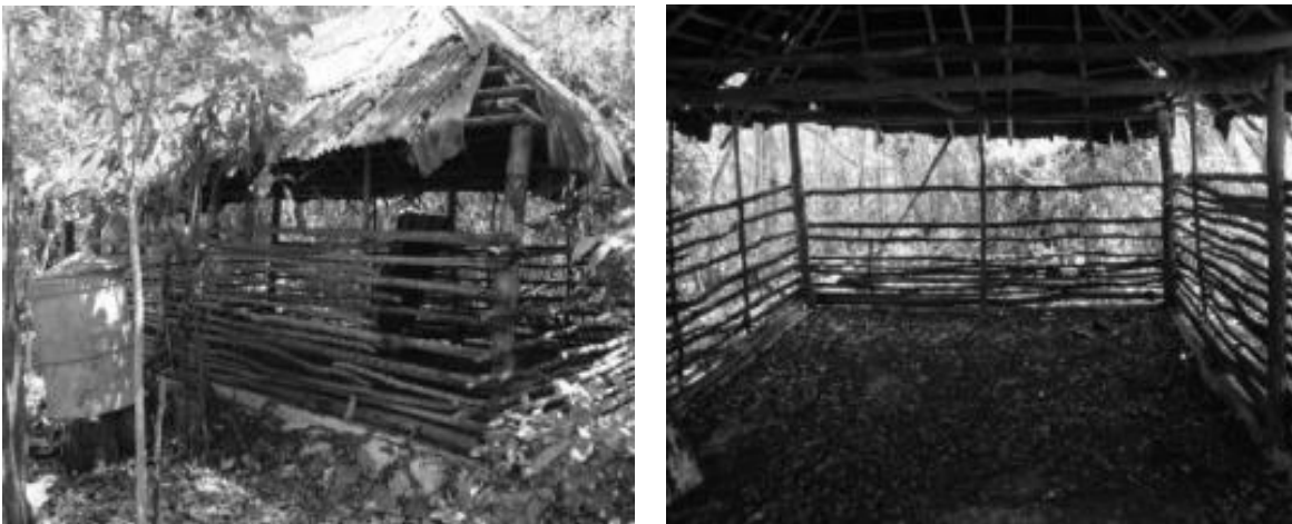
Figuras. 10 y 11. Tinglado vista exterior e interior
