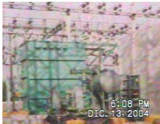
**Figura 2.7** Proceso de llenado de líquido aislante o aceite bajo vacío con circulación en la maquina Stoke.
