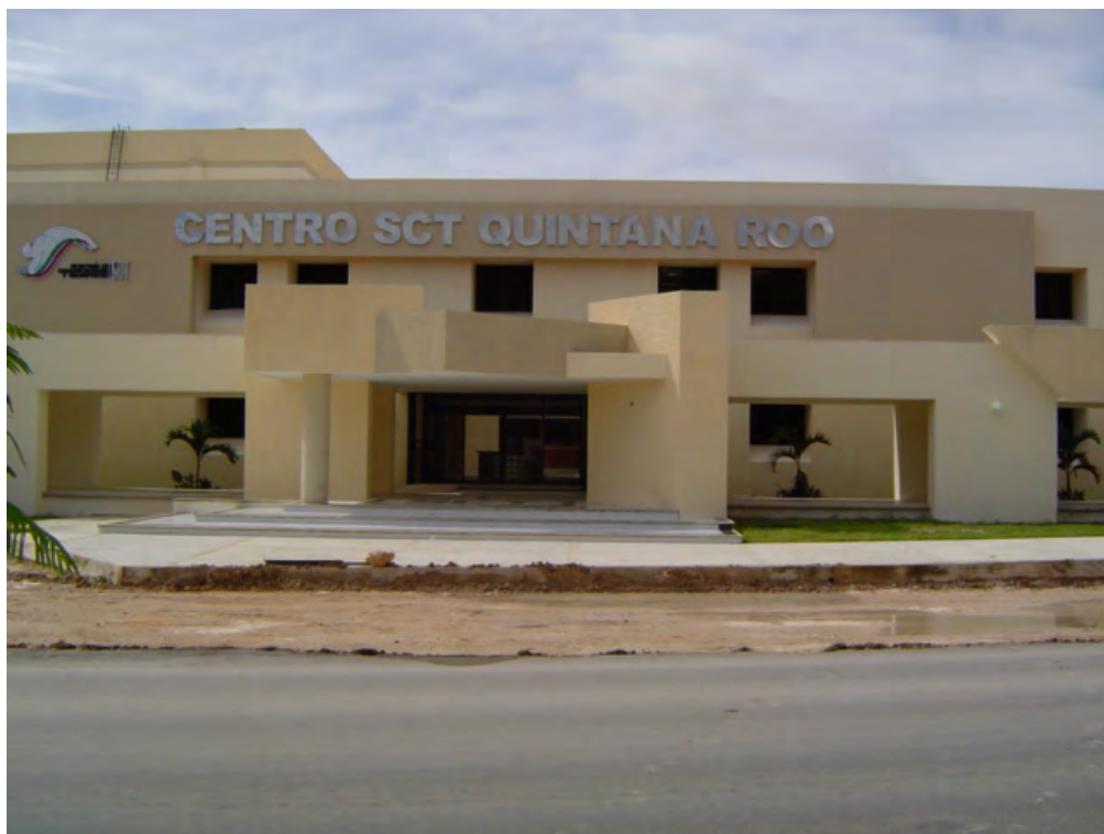
Figura 3.1. Edificio Centro SCT, fachada norte.
