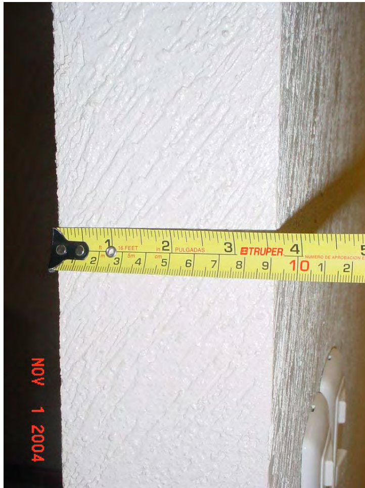
Foto 5. Espesor de Muro Interior de Tabla Roca.
