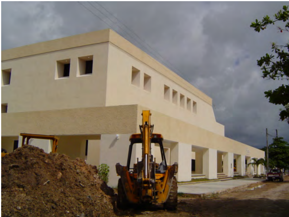
Figura 3.3. Edificio Centro SCT, fachada este.
