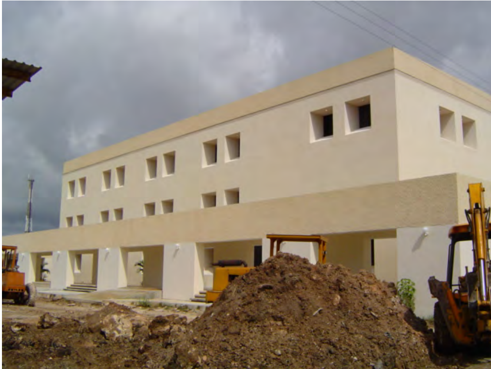
Figura 3.2. Edificio Centro SCT, fachada sur.
