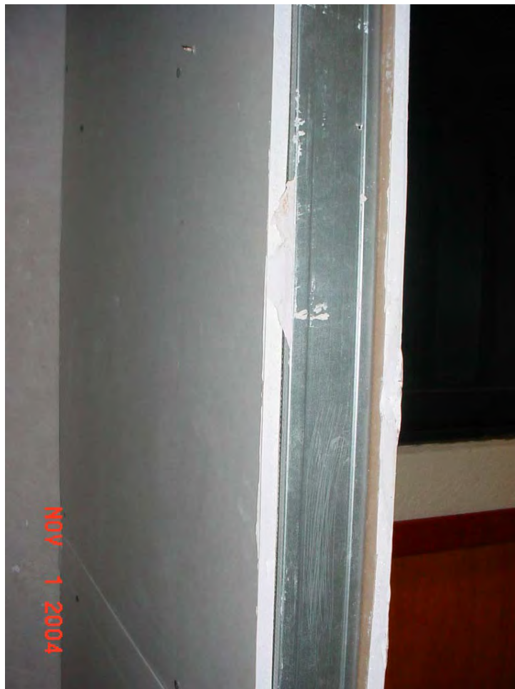
Foto 4. Muro Interior de Tabla Roca (Yeso-Aire-Yeso)
