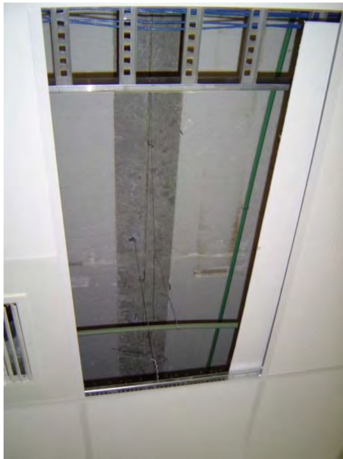
Foto 2. Vista de la doble vigueta con poliestileno expandido en placa.
