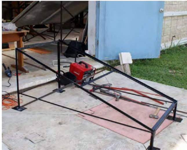
*Figura 3.29 base del colector terminada.*
