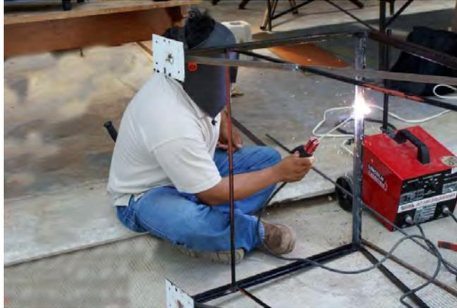
*Figura 3.28. Soldando la base del colector a 18° de inclinación.*
