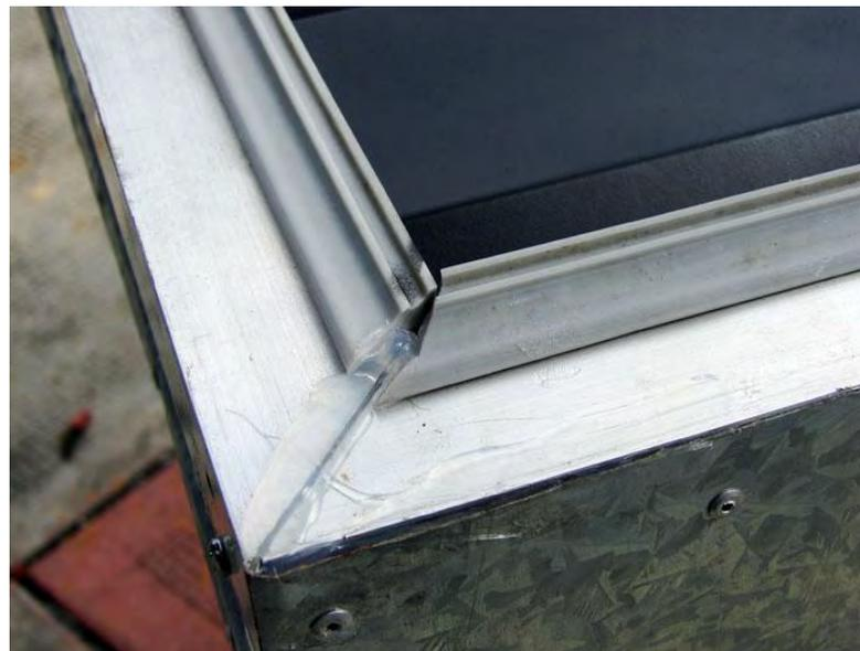
*Figura 3.27 Detalle de la aplicación de silicón en la unión del empaque de vinil para evitar penetración de agua.*
