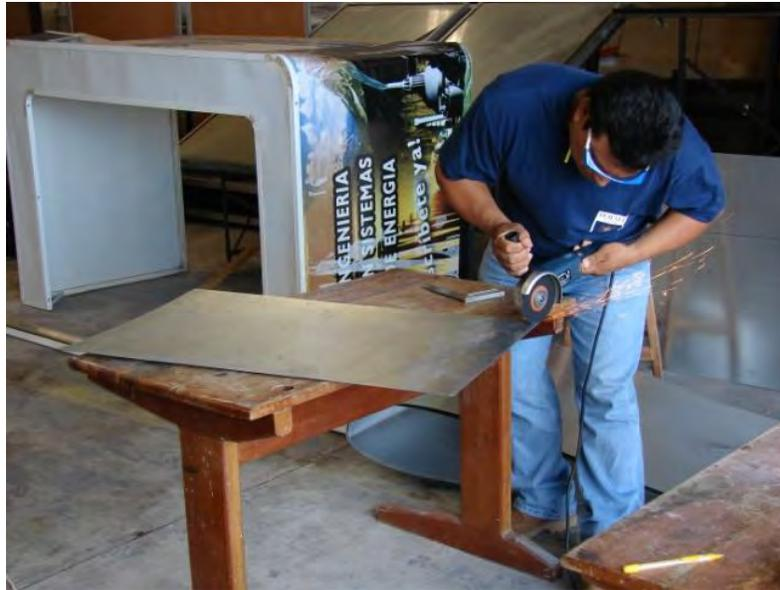
*Figura 3.9. Corte de lámina para el forado de la cabina*
