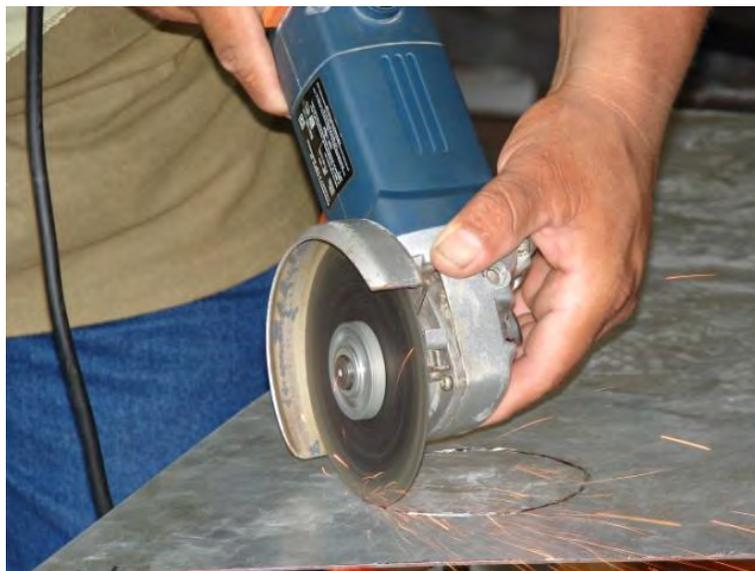
*Figura 3.10. Corte del orificio donde se instalo el extractor de aire.*
