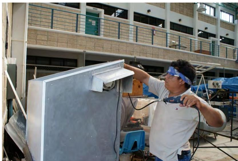
*Figura 3.18 Instalando las cubiertas de los extractores de la cámara de secado.*
