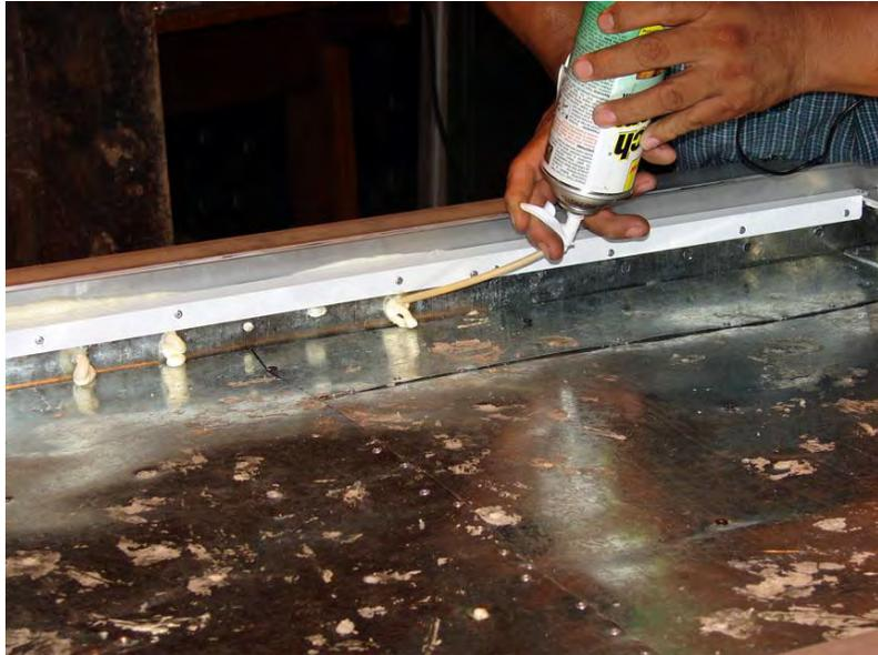
*Figura 3.23 Realizando el llenado de la cámara de aislamiento.*
