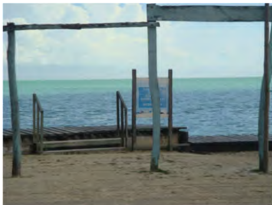
Para acceder al mar es necesario bajar escalones y un corredor, siendo instalaciones inadecuadas para el tránsito de una silla de ruedas. Clave (IAL 16/13-01-15)
