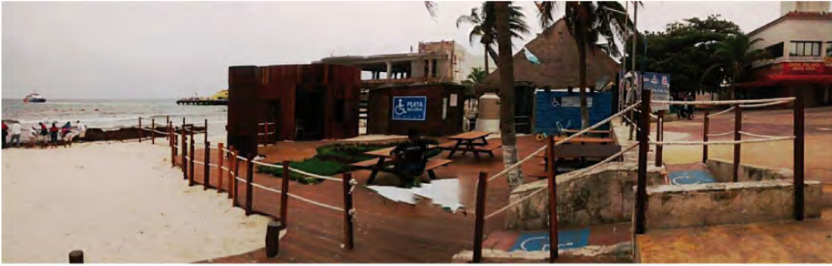
Imagen panorámica de las instalaciones de la playa inclusiva Clave (IAL 40/ 19-06-15)
