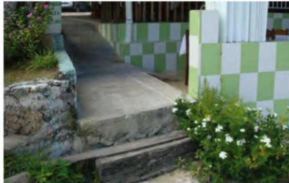
Inaccessibilidad a la playa en un restaurante; el único acceso es a través de escaleras Clave (IAL 15/13-01-15)
