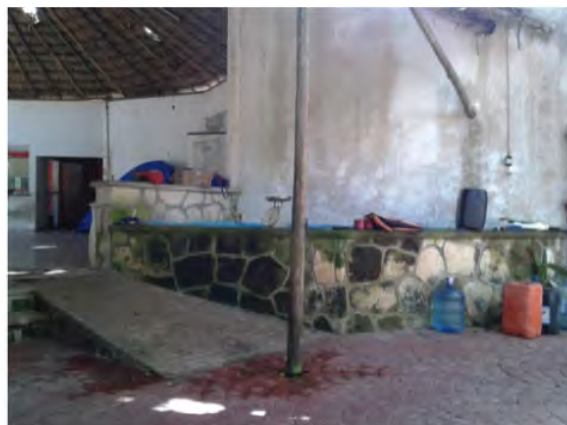
Poste de madera que impide el paso a la rampa de acceso de la palapa de Punta Catalán. Clave (IAL 02/13-01-15)
