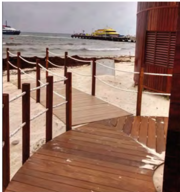
Pasarela de acceso a la playa Clave (IAL 39/ 19-06-15)
