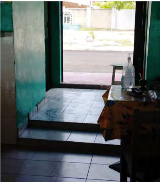
Serie de escalones localizados a la entrada del restaurante uno, impidiendo el tránsito libre a través de ella. Clave (IAL 20/ 02-05-15)
