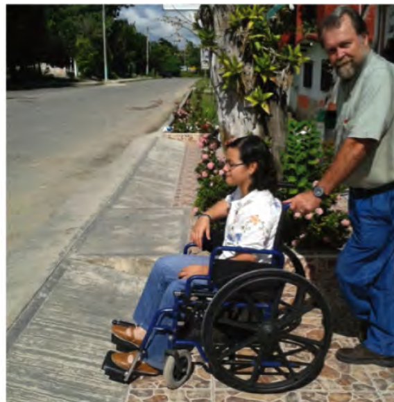
Rampa con una inclinación elevada, localizada a la entrada de un restaurante. Clave (IAL 09/13-01-15)
