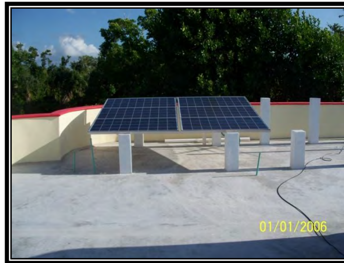
Figura 4.- Arreglo fotovoltaico (caso 1).
