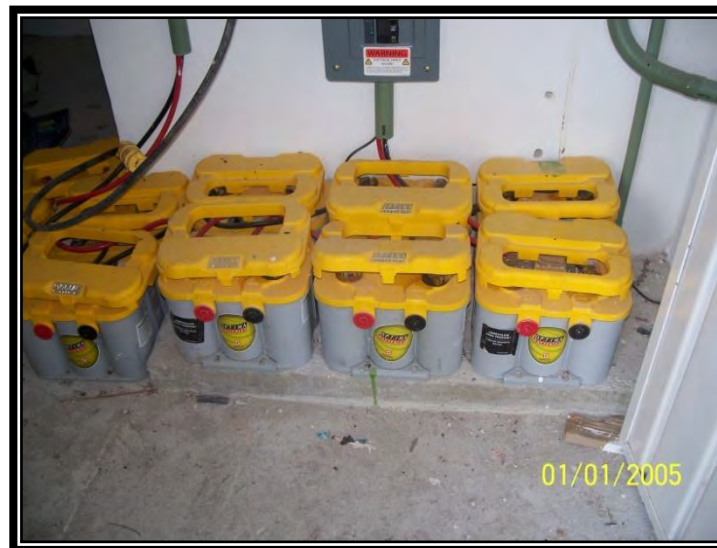
Figura 11.- Conexión de baterías (caso 2).
