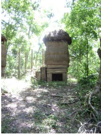
Foto 13.- Baños Ecológicos construidos en la zona del mirador.
