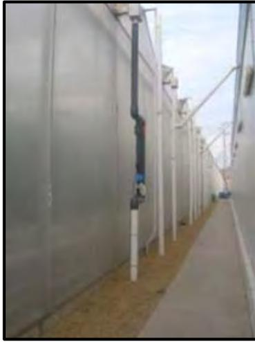
Figura 12. Sistema de tuberías para canalizar el agua hacia los contenedores.
