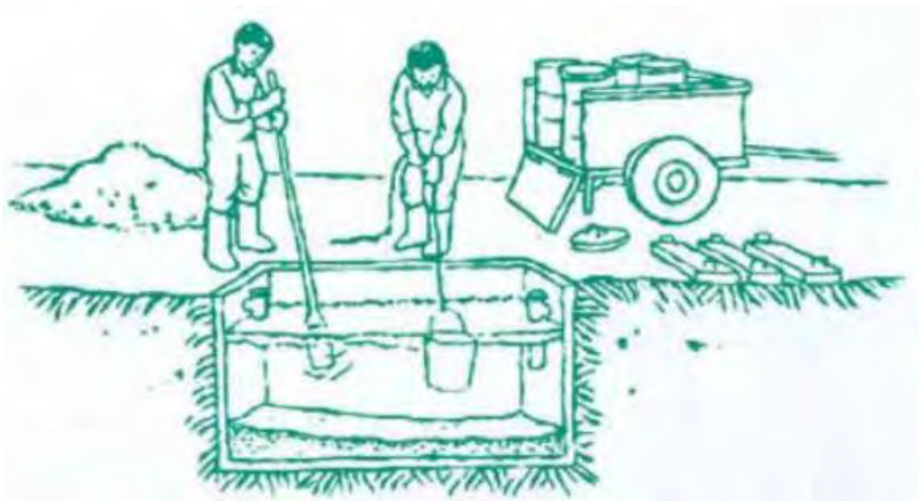
Figura 3.13. Extracción de lodo de una letrina húmeda
