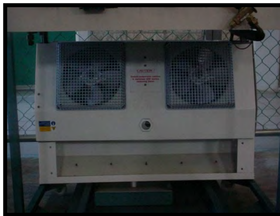
Figura III.5. Unidad evaporadora.
