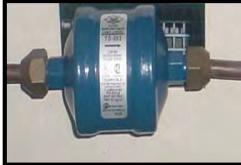
Figura III.8. Filtro secador.
