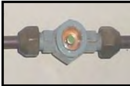
Figura III.9. Válvula de expansión.
