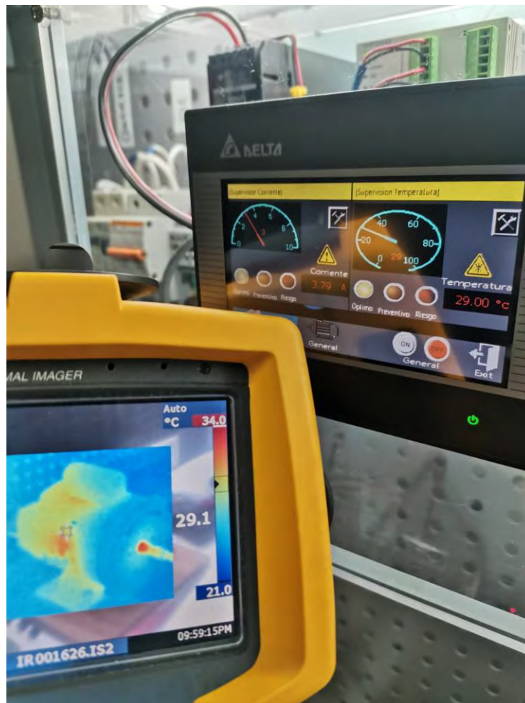
Figura 99 Medición de temperatura Fluke y LM35 en la pantalla HMI
