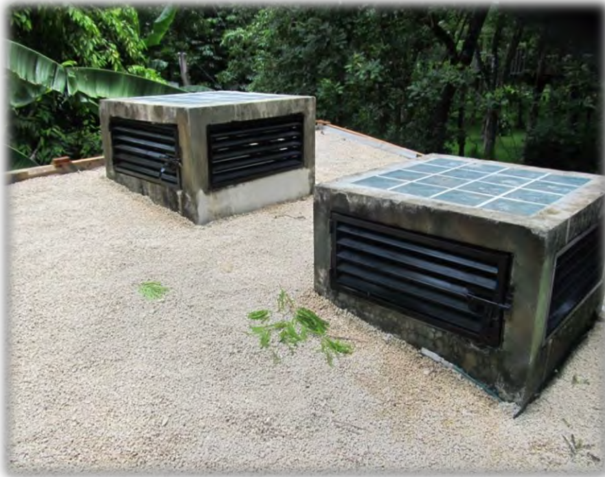
Imagen 17.- Instalación capa drenante
