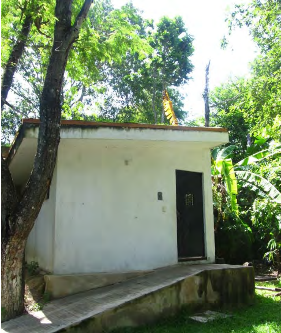
Imagen 21.- Instalación de la cubierta verde finalizada
