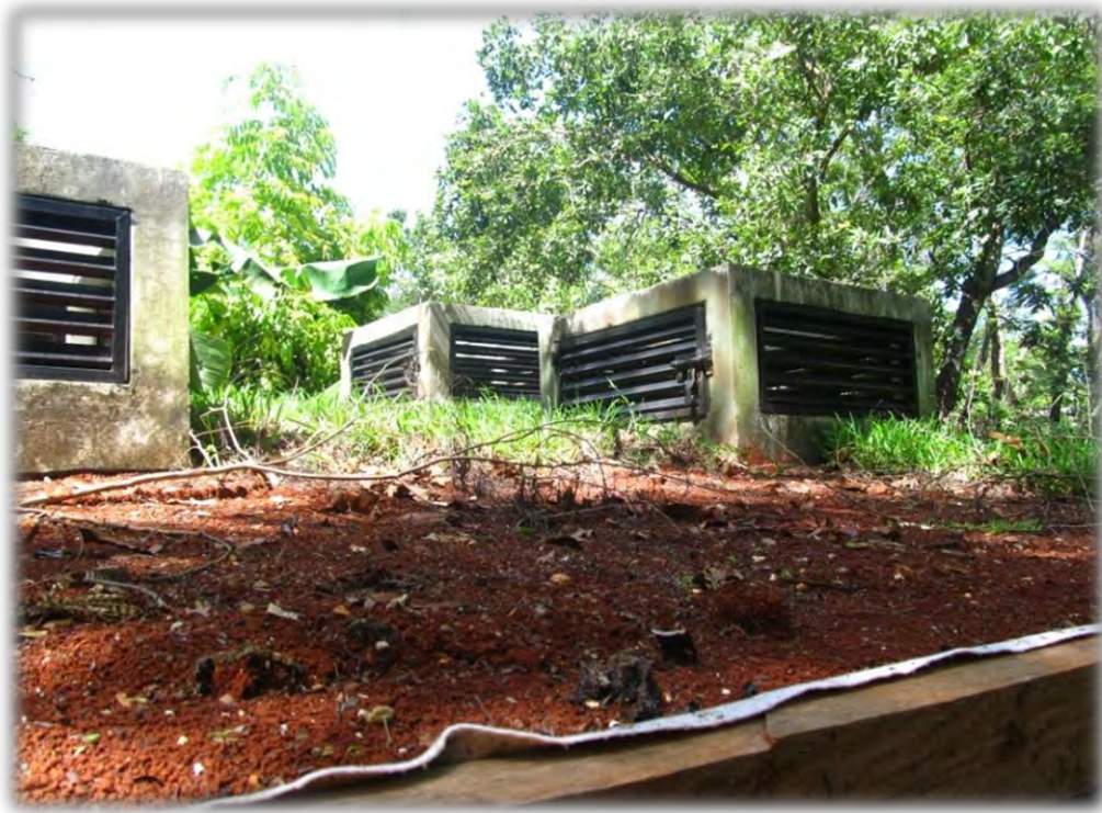
Imagen 19.- Instalación del sustrato
