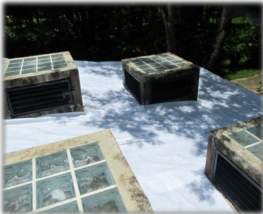
Imagen 18.- Instalación del filtro
