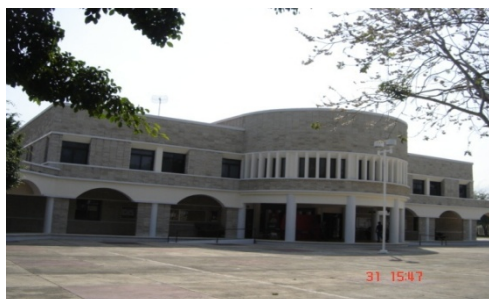
Figura 1.2. Fachada del Edificio Rectoría
