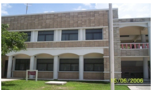
Figura 1.3. Fachada del Edificio D.
