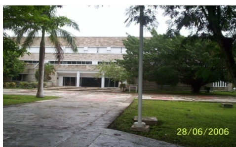
Figura 1.4. Fachada del Edificio Biblioteca.
