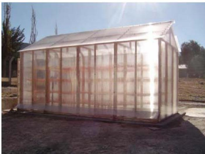
Figura 1.5. Secador-invernadero de policarbonato.
