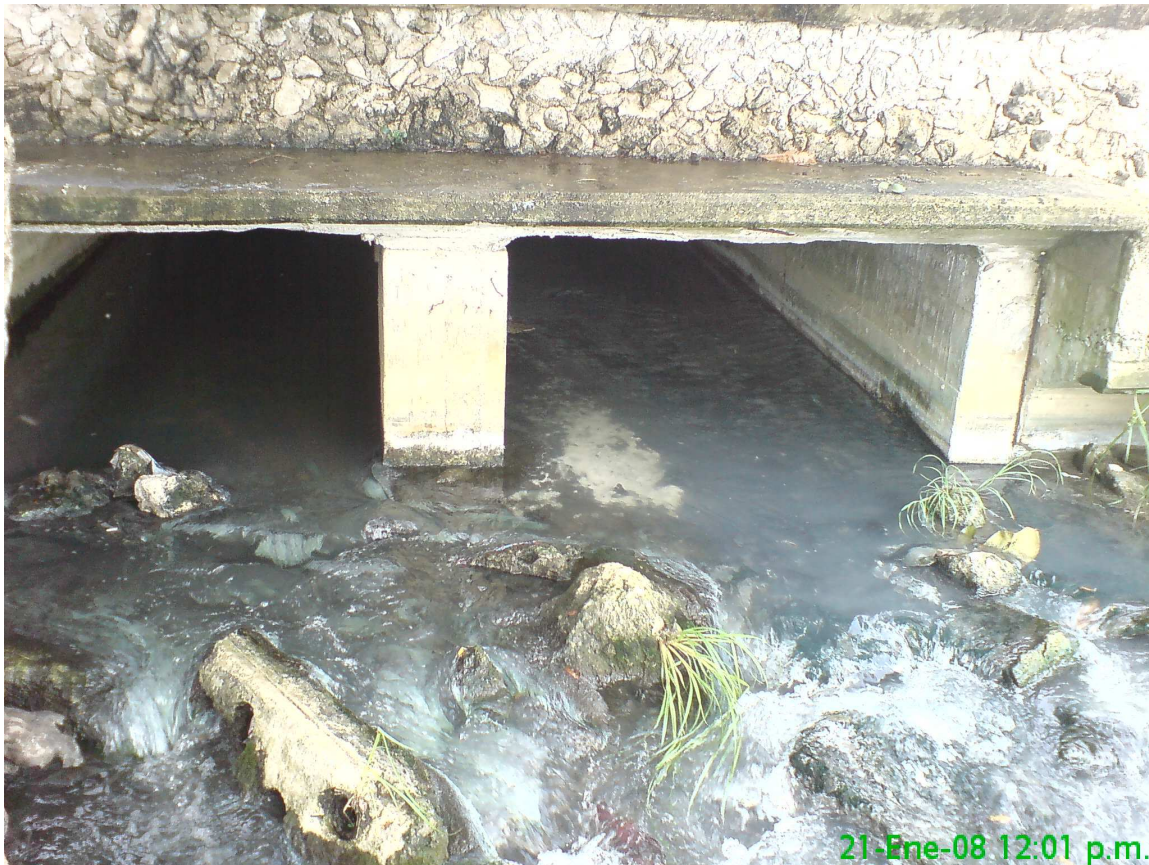
Figura 40. Efluente pluvial del muelle.
