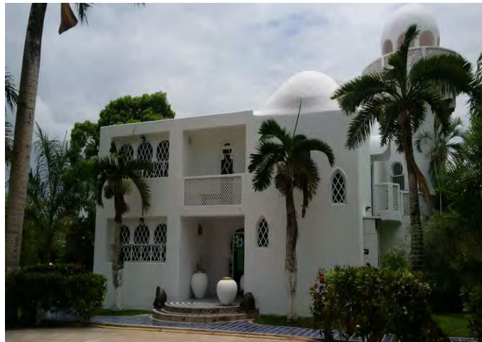
Figura 5.2.- Vista frontal de edificio “A”.
